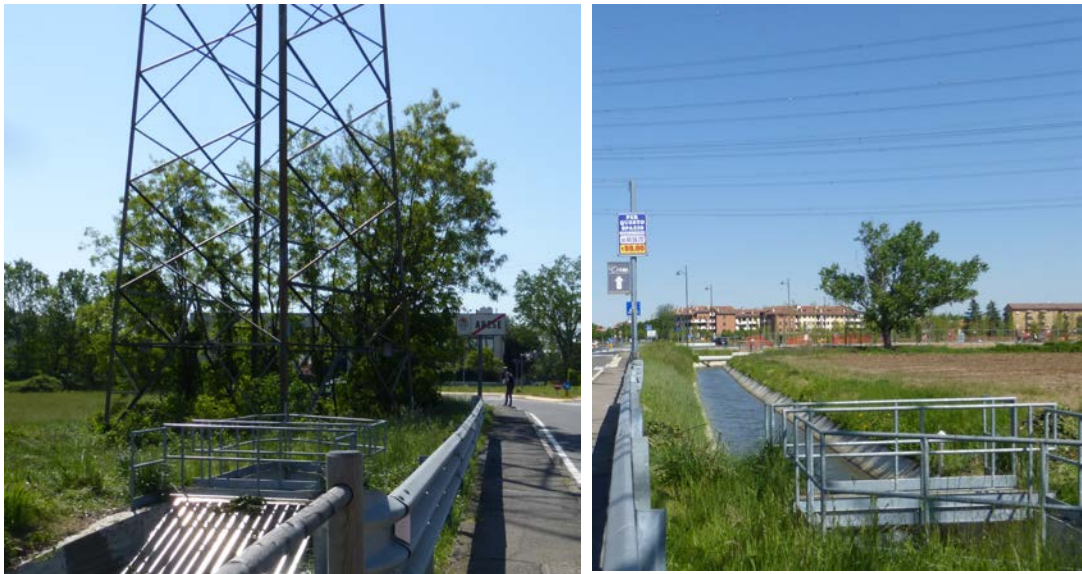
Fig. 6 – IL TRALICCIO T.3 ed IL CANALE NUOVO SECONDARIO VILLORESI
